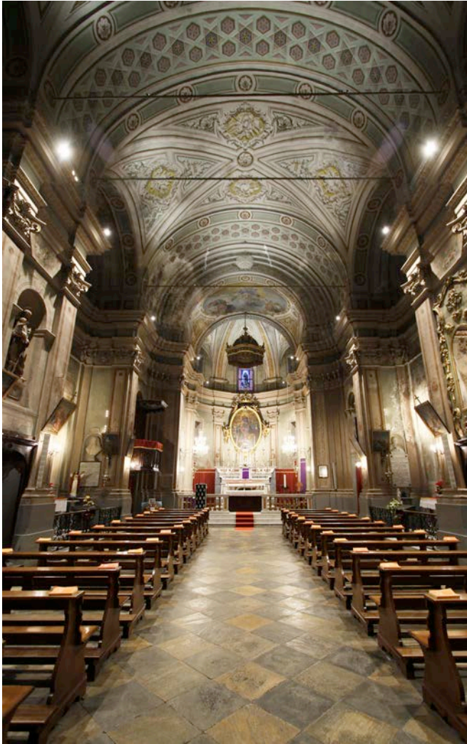
Vista dell'aula verso l'altare a seguito dell'installazione illuminotecnica.
