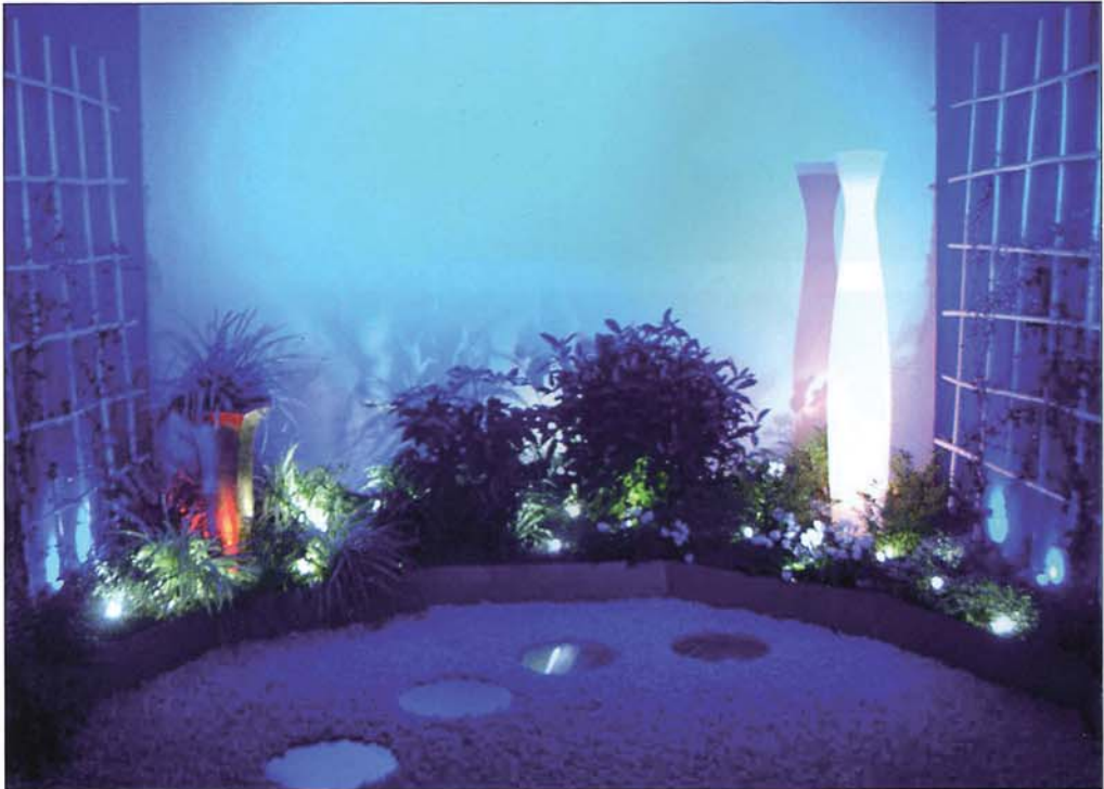
Figura 3.84 Bordatura verde con fioriture rischiarata con micro-apparecchi equipaggiati con LED di bassa potenza infissi nel terreno vegetale.
